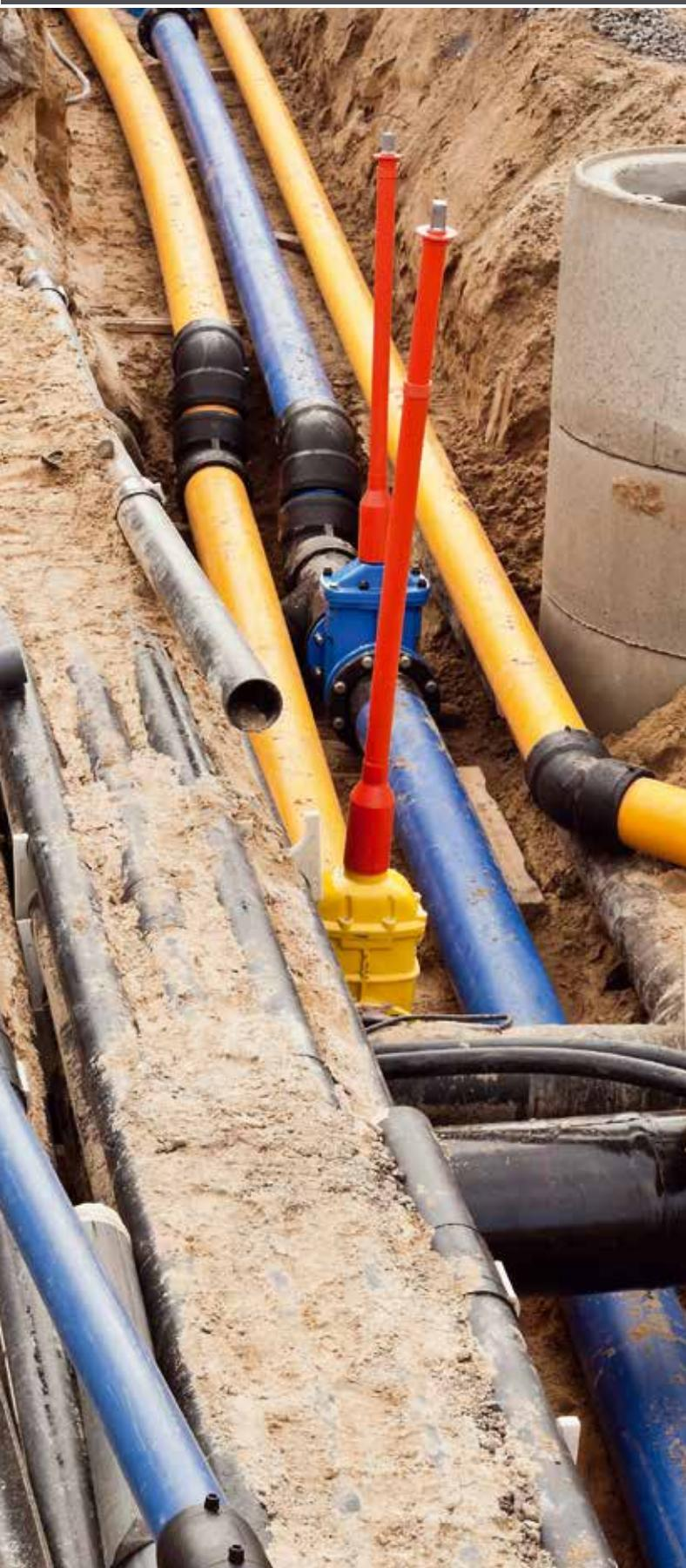
**Sa composition en plastique allège réellement sa mise en place.**
