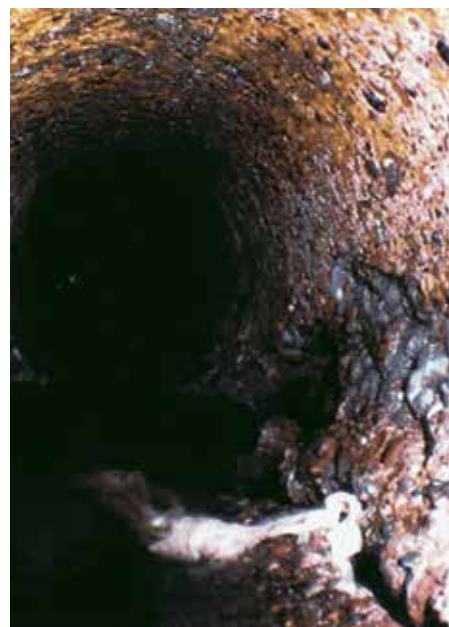
Canalisation en béton corrodée
