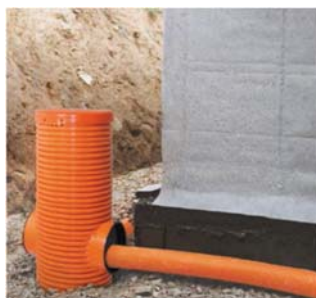
Figure 17 – Exemple d'installation du système Opti-drain
